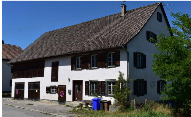
In diesem ehemaligen Bauernhaus wird das Internat eingerichtet
